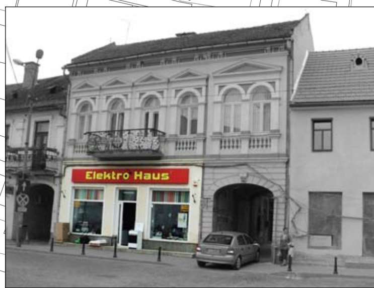
Összkép rontó homlokzat átalakítás, reklámtábla
