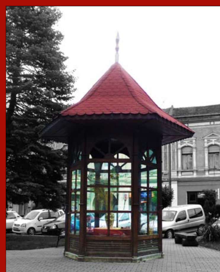
Tér összképéhez nem illő építmény
